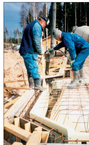
Finnfoamiga saavutatakse tõhus keltsatõke ning hea külmakatketus sokli ja põranda vahel. Finnfoami vastupidavus tuleb kasuks ka sokliõhedes ja valuvormides.
