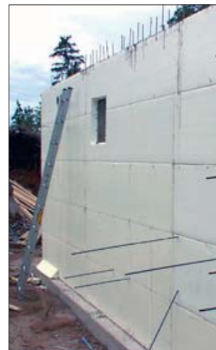
Finnfoam on ka tõhus keldriseina soojusisoleermaterjal. Tänu tihedale kargstruktuurile ei pääse vesi ning koos sellega peen irdpinnas isoleermaterjali sisse. Ka ei ole puujuurtel võimalik vee järel Finnfoami sisse tungida.
